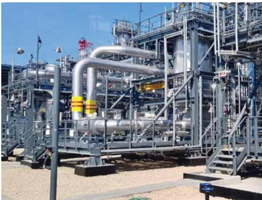
ского участка газопровода «Северный поток-2», прокладываемого по дну Балтийского моря, до приемного терминала на побережье Германии. На КС «Славянская» предусмотрено устройство одиннадцати газоперекачивающих агрегатов суммарной мощностью 352 МВт, что делает ее одной из самых мощных компрессорных станций в мире.
